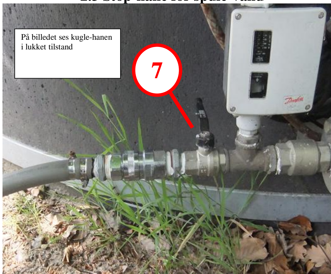
7: Kugle-hane for spulevand: Åbne / lukker for spule vand
